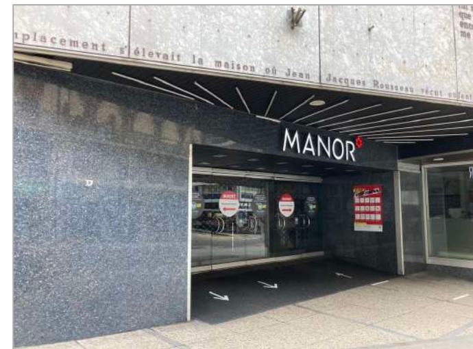
Figure 7: Entrée Manor, rue de Coutance, façade en Larvikite. 7
