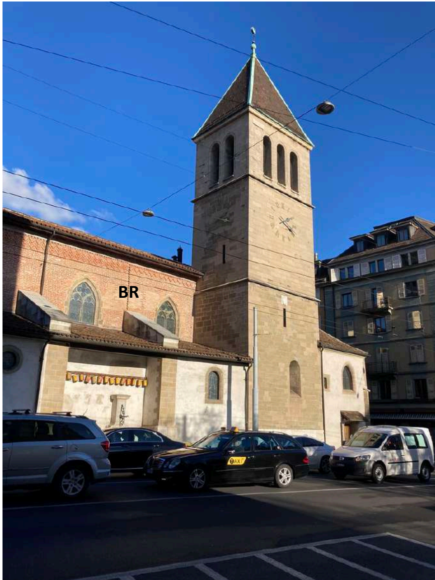
Figure 55: temple de Saint-Gervais, rue des Terreaux-du-Temple 1. BR: briques de production locale, CB: Calcaire blanc, MR: Molasse rouge.
