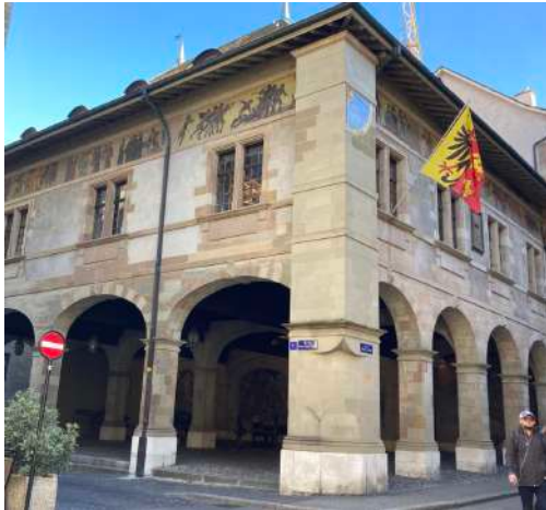
Figure 53: Ancien arsenal en Molasse rouge (fortement restaurée) sur une base en Calcaire blanc .
