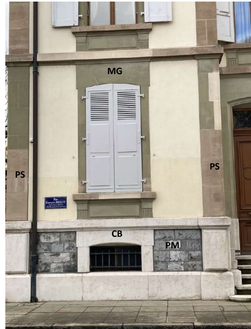
Figure 32: rénovation d'une maison dans la rue François Bellot avec ses différentes pierres de taille: CB: Calcaire blanc, MG: Molasse grise, PM: Pierre de Meillerie, PS: roche de type Pierre de Savonnières en remplacement de la Molasse.
