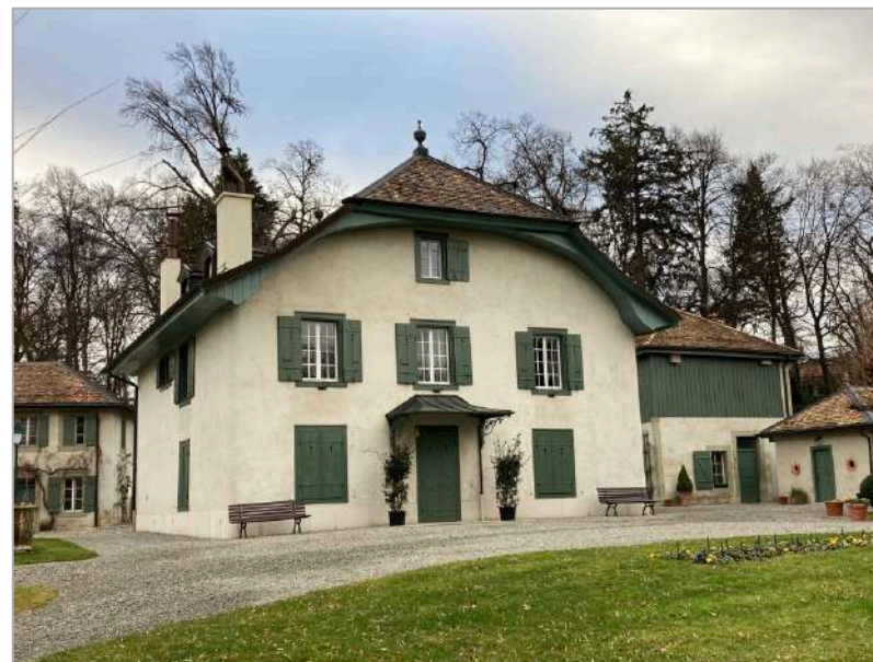
Figure 46: Mairie de Vandoeuvres, une belle bâtisse en Pisé , inaugurée en 1775, rénovée en 2011.
