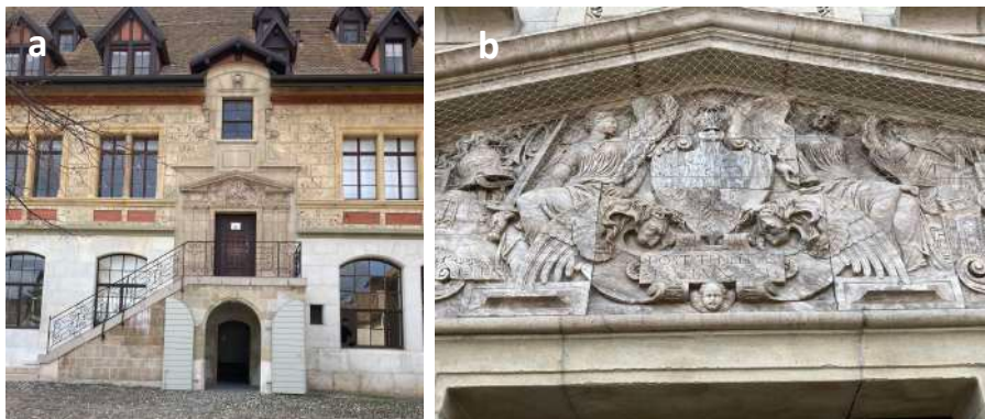
Figure 35 a: rampe et porte d'entrée de l'aile sud depuis la cour du collège en Molasses diverses; b: bas-relief en marbre bicolore au-dessus de la porte .
