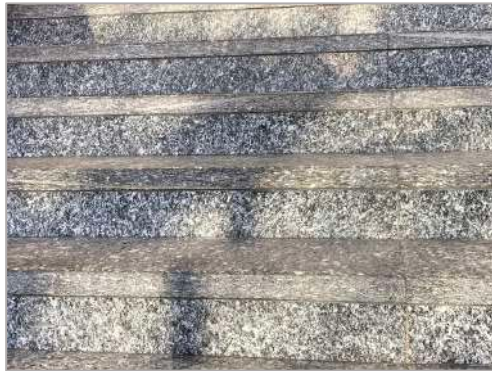
Figure 2: actuellement, granites et gneiss sont essentiellement utilisés pour des éléments soumis à une forte usure, tels que les trottoirs, les bordures de routes et les marches d'escalier. Photo: escalier en gneiss dans le passage souterrain de la gare de Cornavin.
