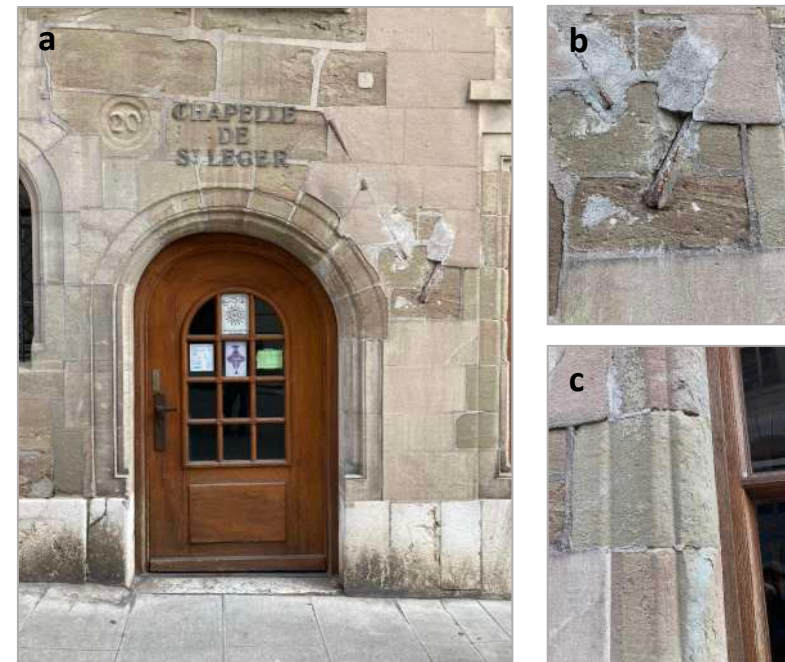
Figure 39: altération de la Molasse rouge, exemple de la Chapelle de Saint-Léger, 20 rue Saint-Léger.
