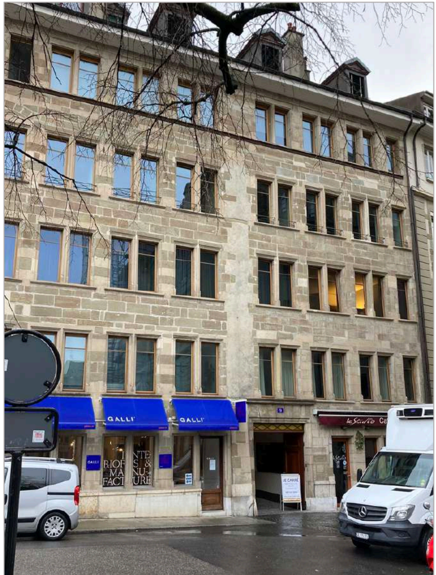
Figure 41: belle façade gothique en Molasse rouge sur la Place du Bourg-de-Four.
