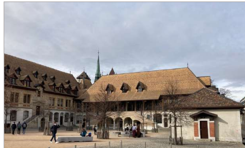
Figure 33: anciens bâtiments du Collège Calvin, vue depuis l'est; à gauche l'aile sud, au centre l'aile central.
