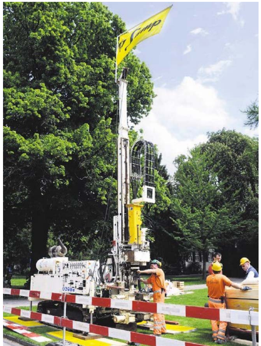
Sondierbohrgerät und Rotationskernbohrer holen den Untergrund für Geologen und Publikum ans Tageslicht. Bild: Heinz Diener
